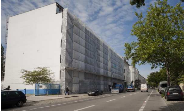
Außenansicht der Lützowstraße 73
