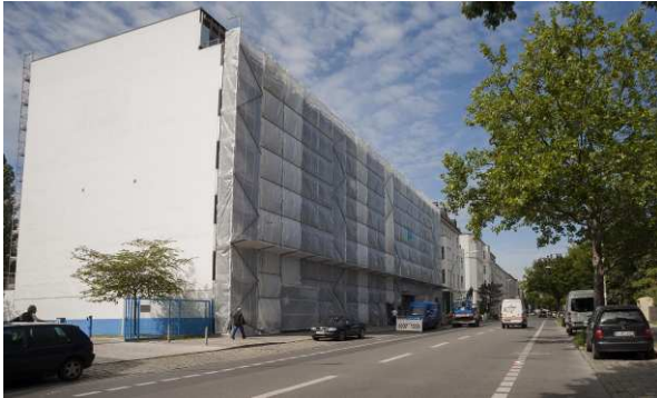
Exterior view, Lützowstraße 73
